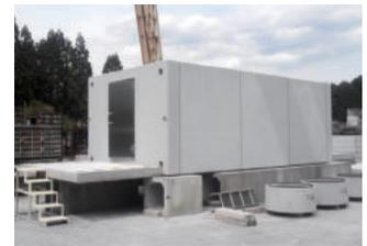
PCコンクリートボックス形状により、通常のシェルター建設より大幅に工期を短くすることが可能です。
