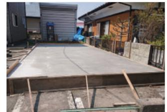
枠組み後コンクリートを流し込み地盤を固めます。（設置場所の状況により必要ない場合もございます。）
